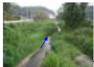
伊保川4.25k付近橋梁より下流を望む
