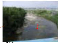
0.0k 籠川 荒井橋(0.0k)より上流を望む
