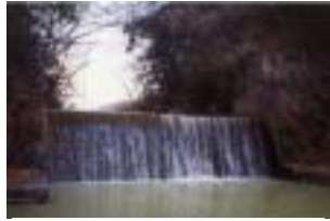
高低差の大きな落差工（伊保川）
