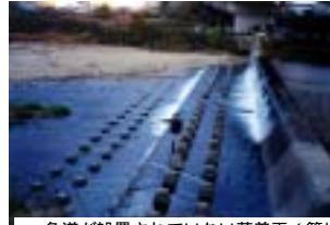
魚道が設置されていない落差工（籠川）
