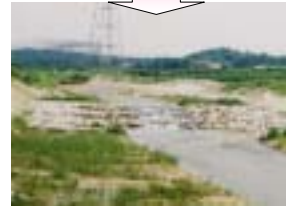
魚類の往来に配慮した落差工（籠川）
