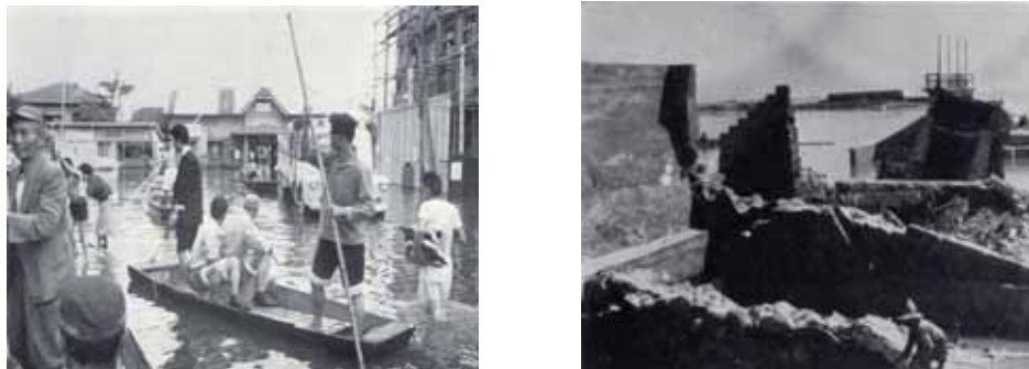
写真 - 4 被災状況 (津島駅前(左)、筏川樋門の被害 (右))
