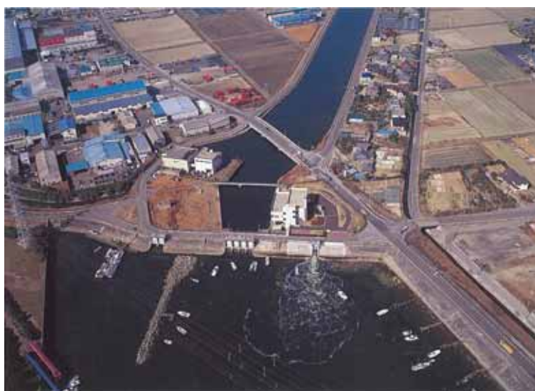
写真 - 6 筏川排水機場
