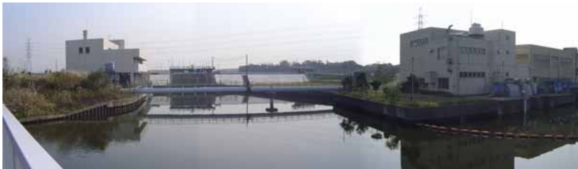
写真 - 1 筏川排水機場
