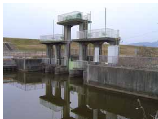
写真 - 3 佐屋川水門
