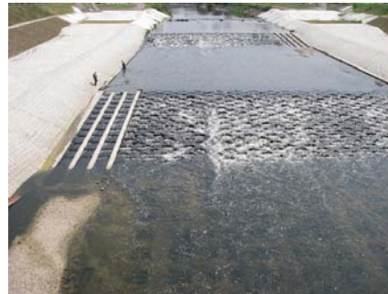
魚道のある落差工
