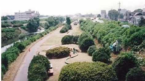
高水敷の整備
