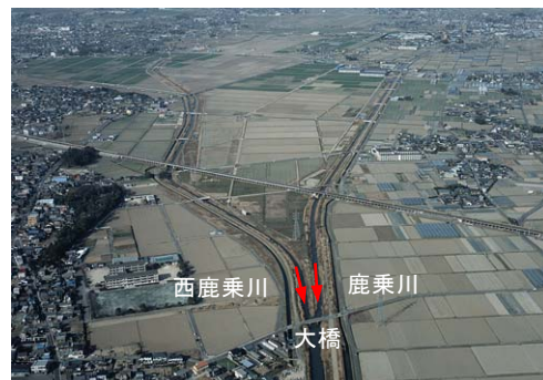
写真-7 西鹿乗川合流点 9.0km
