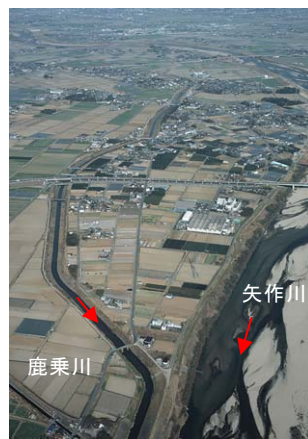
写真-11 県管理区間下流端付近 3.6km
