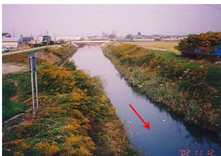
写真-6 東鹿乗橋付近 10.8km (上流望む)
