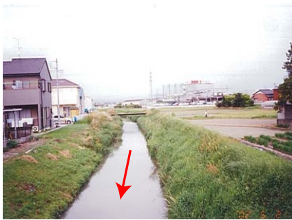
写真-4 まきうち 牧内橋付近 13.1km (上流望む)
