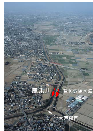
写真-9 木戸樋門付近 6.2km
