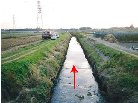
写真-12 西鹿乗橋付近 2.4km (下流望む)
